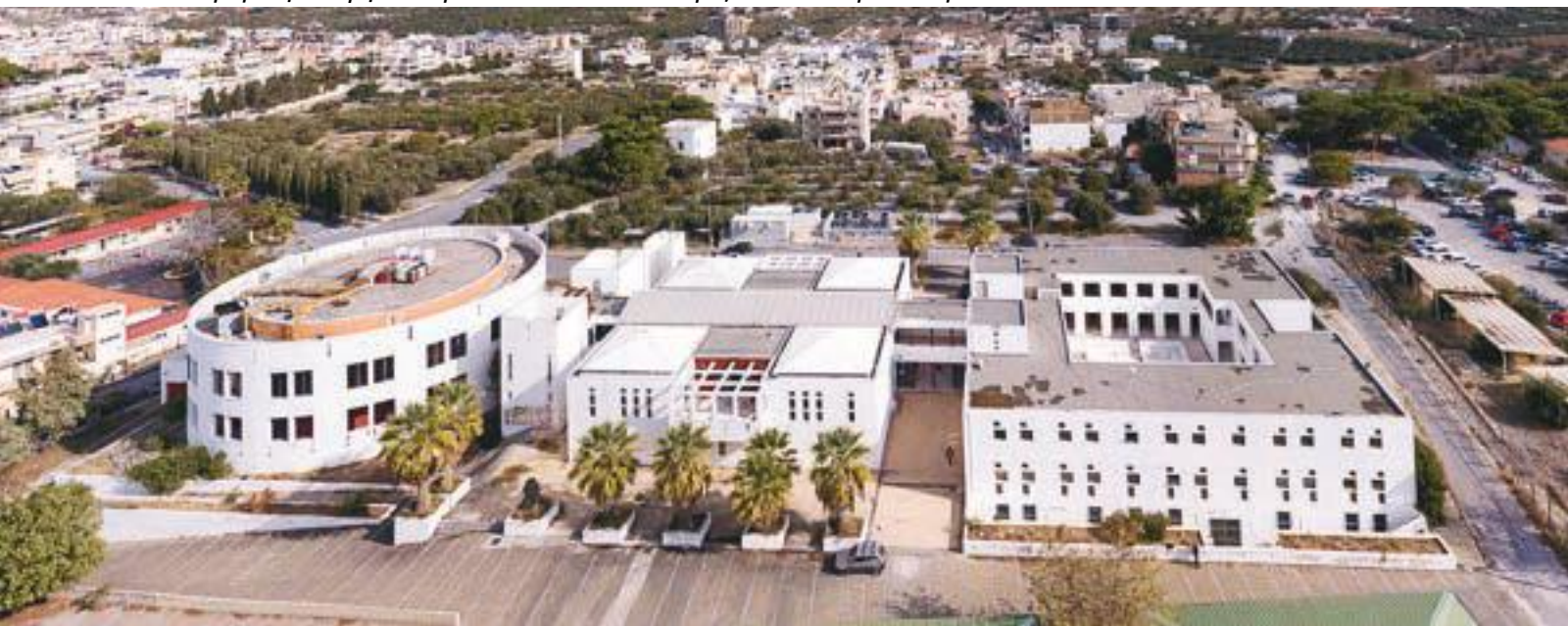
Πανοραμική άποψη των εγκαταστάσεων που στεγάζεται το Κέντρο Δεδομένων Κνωσού
